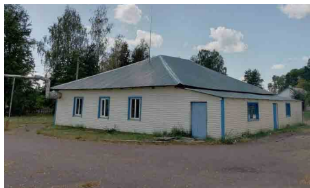
Dach-Renovation Schule Putilovich
