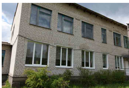
Neue Fenster für Kindergärten und Schulen
