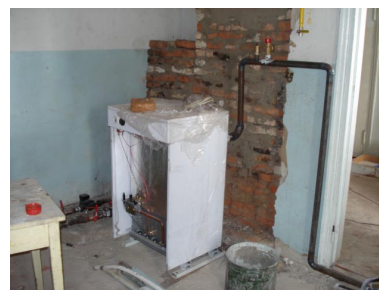
Neue Zentralheizung für das Behandlungszentrum
